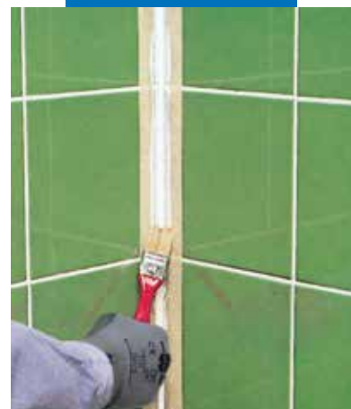
Alisado de la junta con agua jabonosa y un pincel
